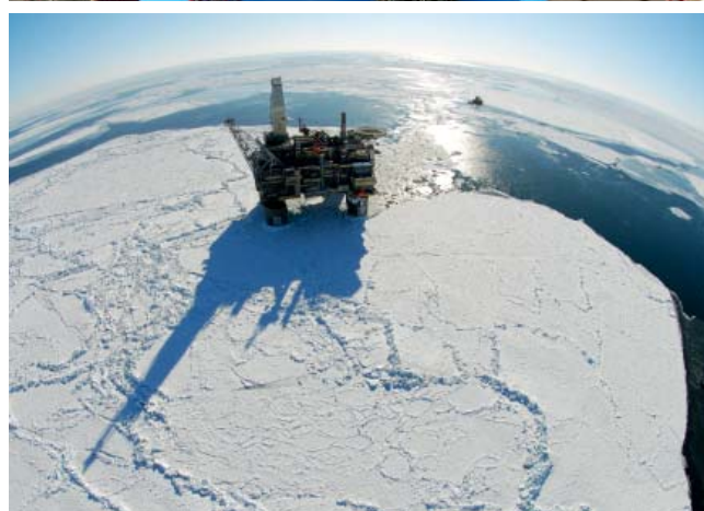
Fot. 2. Instalacja Melkya w Norwegii. Fot. Harald Pettersen - Statoil
